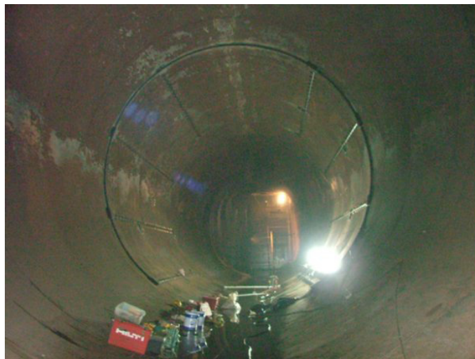
Figura 2. Instalación de los sensores del sistema de medición ultrasónica de flujos turbinados en centrales hidroeléctricas.
