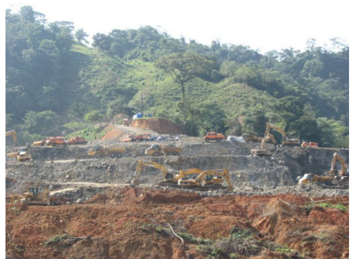
Figura 3. El “Tapón” del río Grijalva, durante los trabajos para escindirlos longitudinalmente a modo de permitir de nuevo el flujo del agua.
